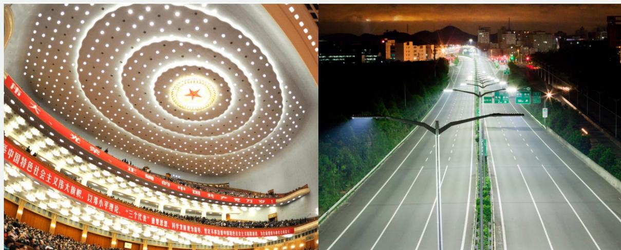
2014年，构建三维自由光学曲面 - 实现高效、均匀照明的系列技术，首次大规模应用展示节电效果在60%以上，推动了我国半导体照明光学工程学科的发展，引领了照明领域的节能减排，获得国家技术发明二等奖。
